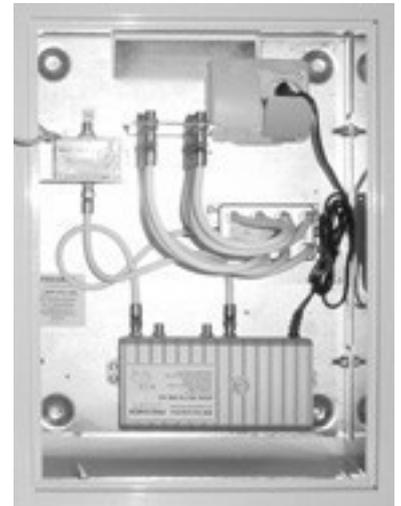
Televes Montageschrank MSR 48 AZ Montageart Aufbau, Ausführung Deckel geschlossen, Werkstoff des Gehäuses Stahl, Höhe 400mm, Breite 300mm, Tiefe 200mm, Mit Montageplatte, Farbe weiß, Schutzart (IP) IP20, Komplett montiert, sehr kurze Montagezeit, incl.
